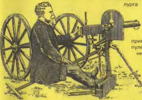
ница Гатлинга, состоявшая на вооружении многих армий, в том числе и русской (см. нижний рисунок). От предшественницы она отличалась блоком из 6 — 10 стволов. Вращая специальное устройство, стрелок последовательно в каждом стволе открывал затвор, при этом выбрасывалась гильза — она была стеклянная! — и
